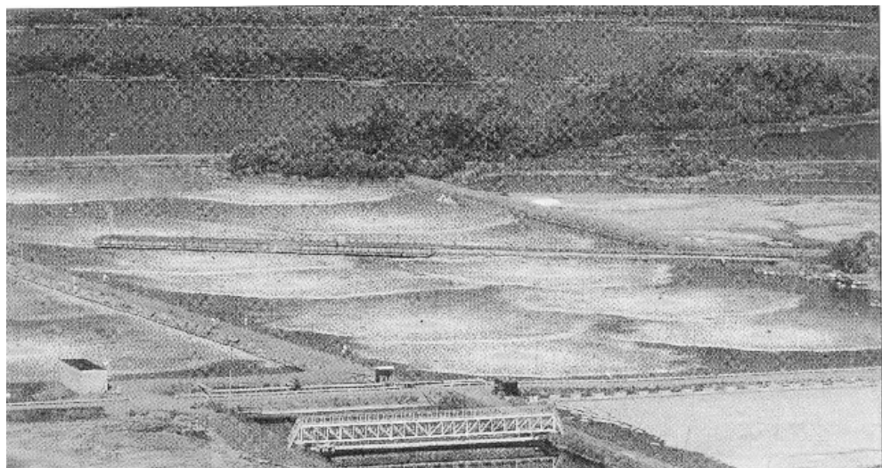
Figur 1 Den luftade dammen är den vanligaste biologiska reningemetoden i svensk massaindustri. Bilden föreställer en luftad damm i Korsnäs.
